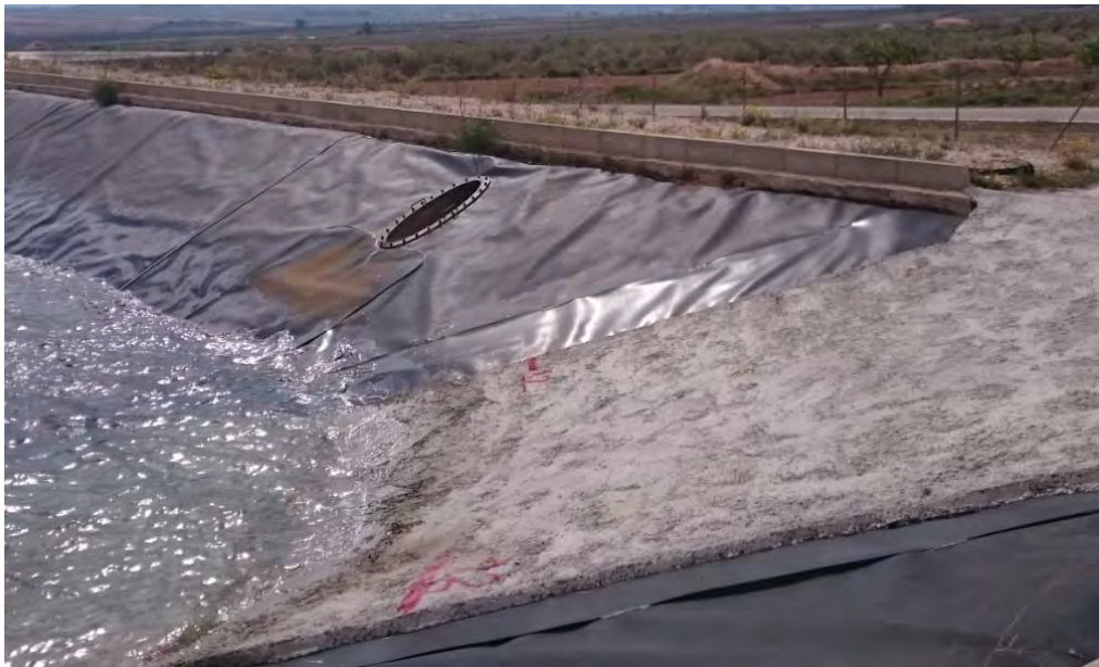
Fotografía nº 8. Rampa de acceso
