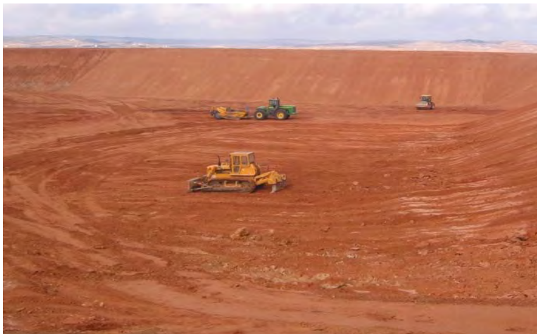
Fotografía nº 1. Movimientos de tierras
