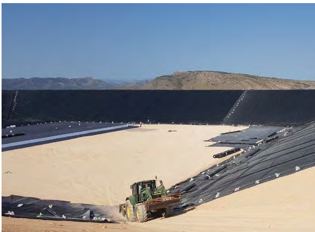
Fotografía nº2. Trabajos de impermeabilización
