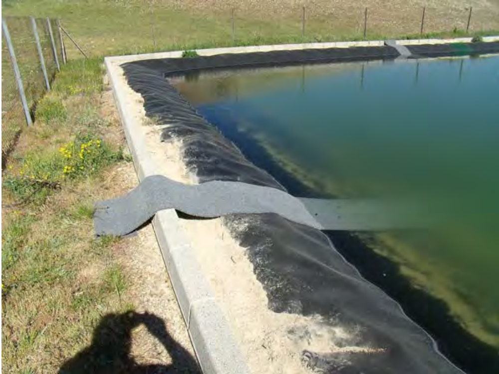
Fotografía nº 15. Rampa de salida de pequeña fauna
