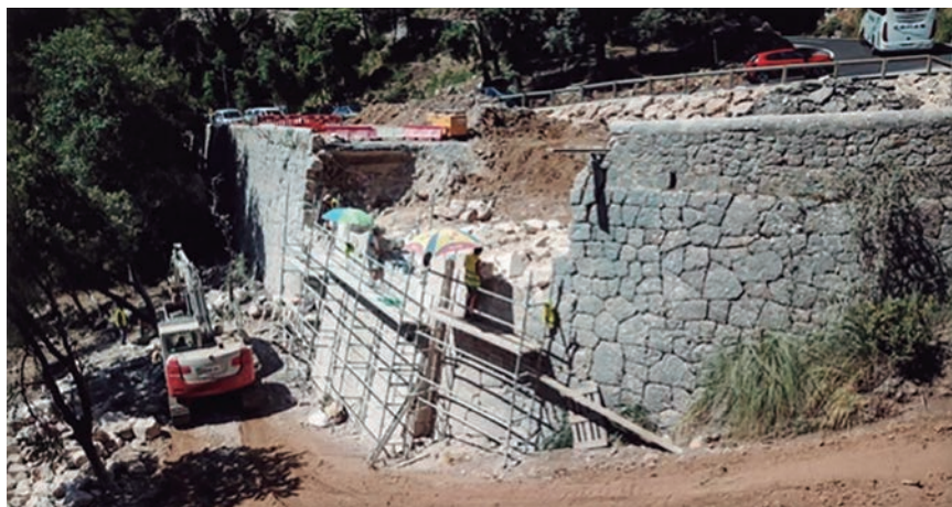
Figura 4. Treballs de reconstrucció del mur
