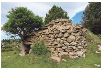
Figura 3. Orri de Baix-1 (WK 13098), barraca de falsa cúpula i de gran altura interior (2,95 m)
