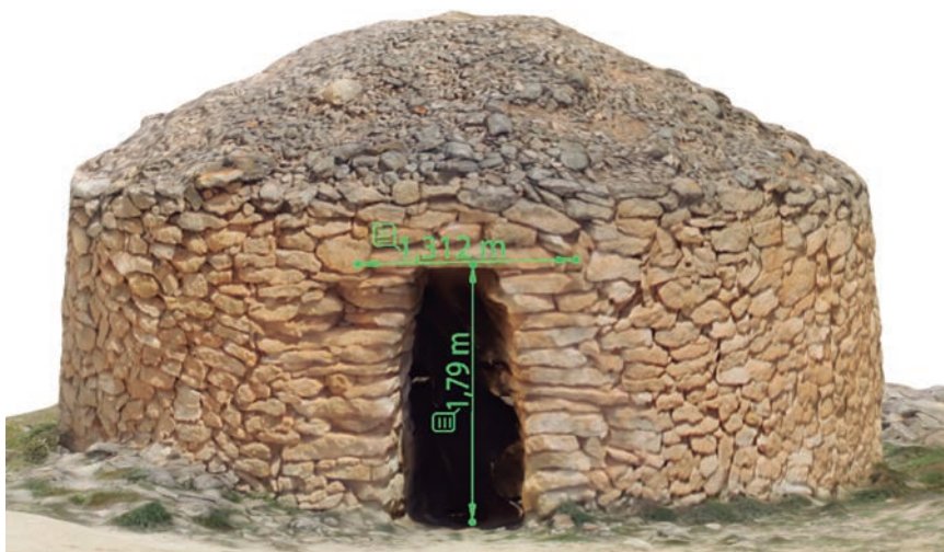
Figura 5. Resultado de algunas mediciones en el PDF 3D (fuente: DYSA-DRONES Y SERVICIOS AERONÁUTICOS)
