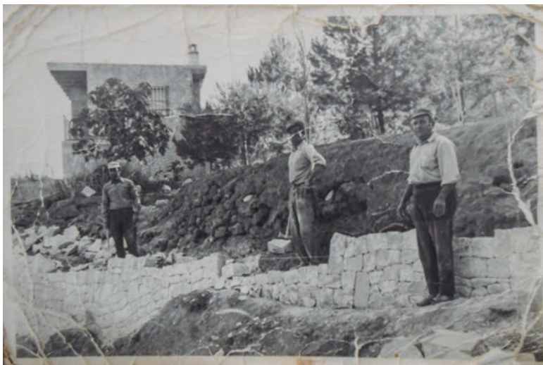
Figura 2. Procés de construcció d'una riba o marge de pedra seca (font: Juan Albert Mira, Juanito el Coliflare )
