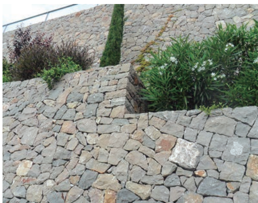
Figura 3. Murs de pedra seca a Orpesa
