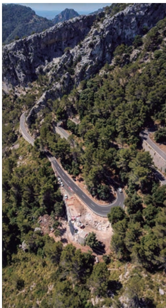
Figura 2. Vista aèria del tram de carretera
