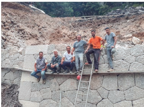
Figura 6. Membres del Gremi de Margers de Mallorca a l'obra
