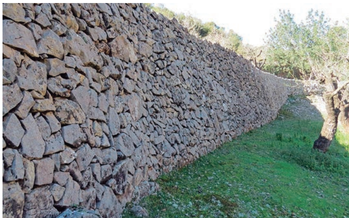
Figura 1. Marge de pedra seca
