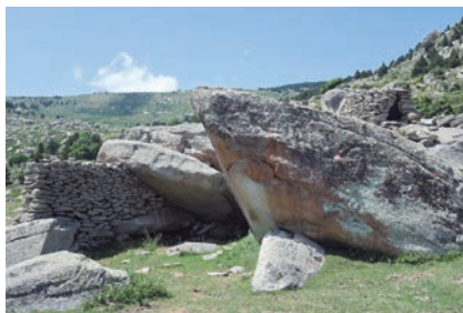
Figura 2. La Balmeta-1 (WK 19827), barraca rústega, amb aprofitament d'una balma a la vora, dins d'un gran tancat de pedra seca
