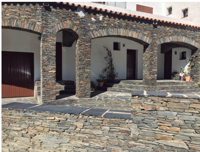
Figura 6. Construcció d'arcs (foto: Miquel Figueras, 2019)
