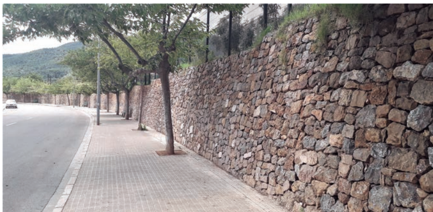
Figura 1. Murs de pedra seca al Parc de la Ceràmica, Onda
