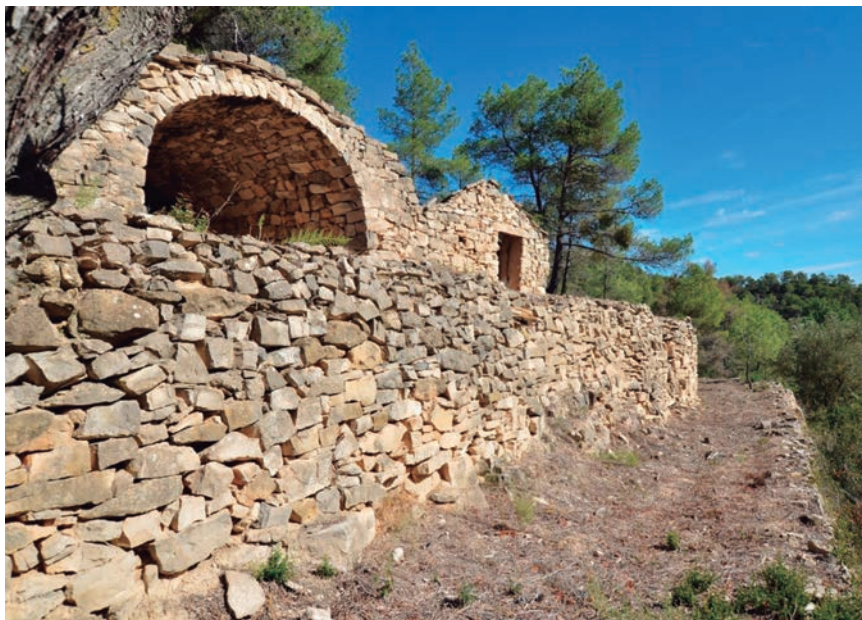
Figura 5. Imatge del conjunt de marge, cabana i perxe a la zona de Pontils de l'Anreba (la Fatarella), (font pròpia)
