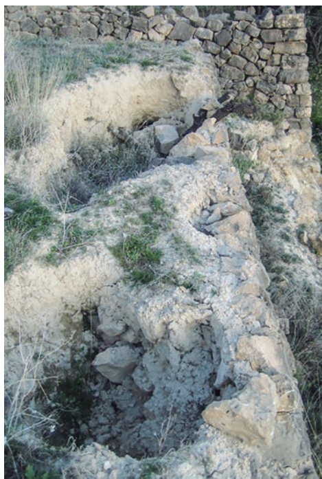
Figura 6. Colapsos ( clots ) por fenómenos de piping en Sella (Serra d'Aitana)
