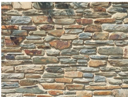
Figura 8. Paret de pedra amb junta reculada (foto: Miquel Figueras, 2019)
