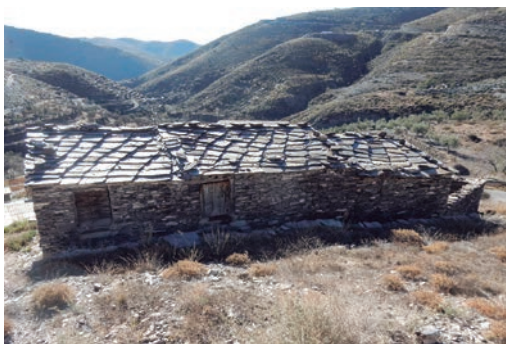
Figura 3. Techumbre de pizarra, cortijo en Olula de Castro (foto: Francisco Majuelos)
