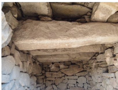
Figura 4. Refugio de cantero, cubierta
