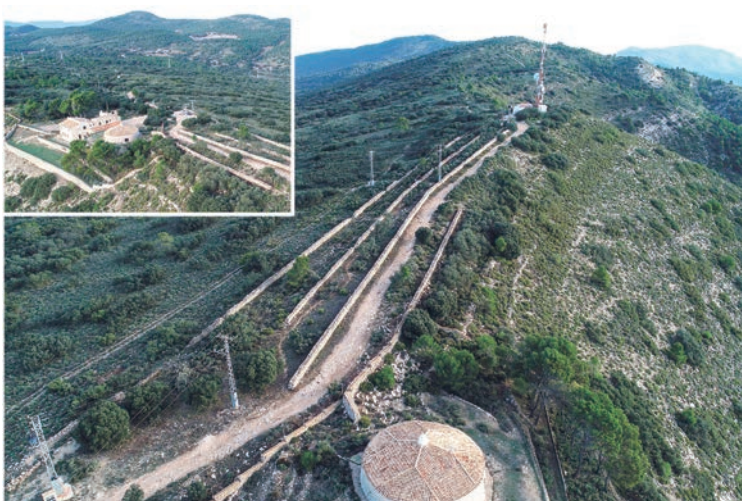
Figura 2. Vistas del conjunto arquitectónico del siglo XIX vinculado al Pou del Surdo: pozo de nieve, muros ventisqueros y la Casa de la Cava (rehabilitada para hotel-restaurante); noviembre de 2018 (fuente: EyeBirdShots)
