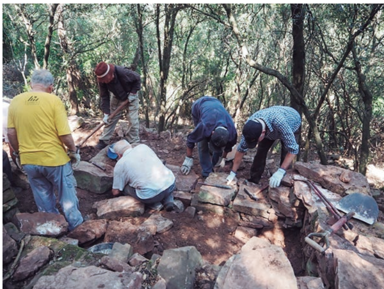
Figura 2. Treballs de restauració de la barraca
