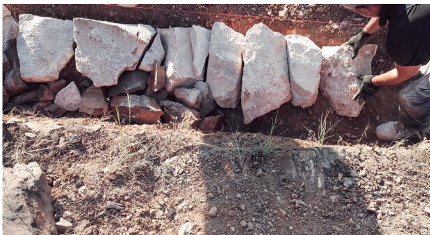
Figura 2. Primera filada de fonament
