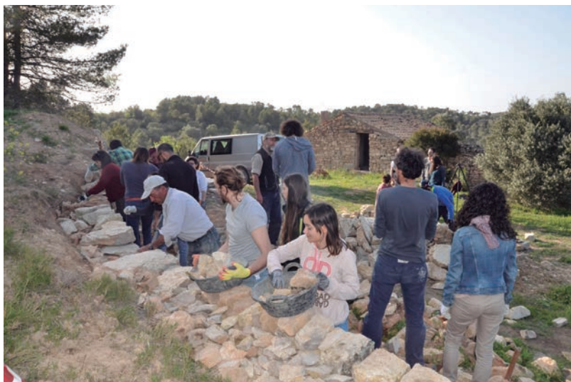
Figura 2. Reconstrucción de un muro de piedra en seco en una de las zonas de trabajo de Pontils de l'Anreba durante el curso
