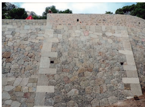
Figura 5. Part del mur finalitzat
