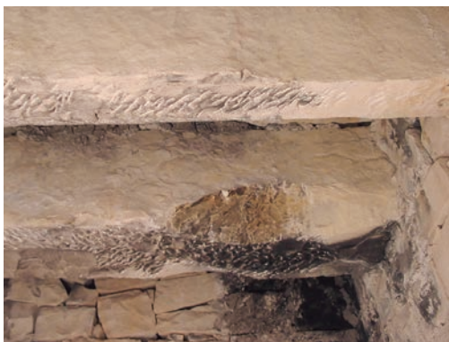
Figura 2. Sistemas de cubrición del refugio con lajas de piedra de grandes dimensiones
