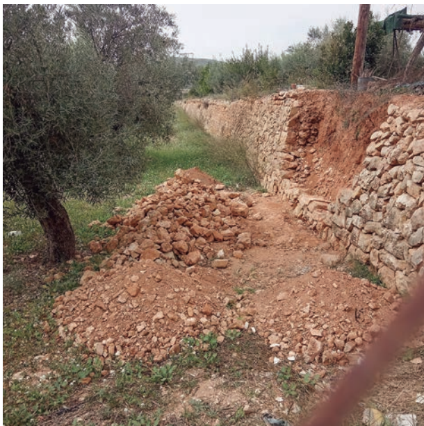
Figura 7. Una riba en reparació
