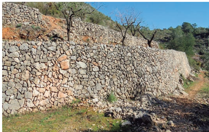
Figura 3. Abancament amb gran desnivell
