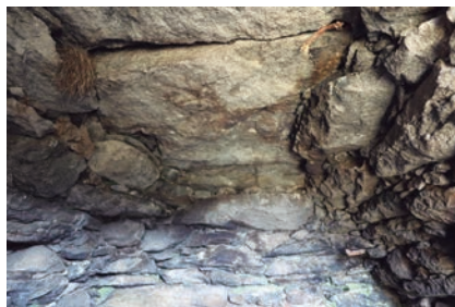
Figura 8. Interior de la barraca de la Jaça d'Avall (WK 13113), amb coberta de grans lloses, una tipologia que es repeteix en altres barraques de la zona
