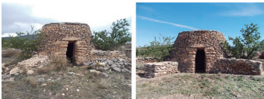
Figura 10. Cuco del Tio Valencià, antes y después de la reconstrucción
