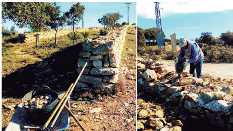
Figura 7. En el interior de los muros ventisqueros se colocó ripio y grava del lugar mientras se iban trabando las piedras de mayor tamaño; noviembre de 2018 (fotos: Arpa Patrimonio S. L.)
