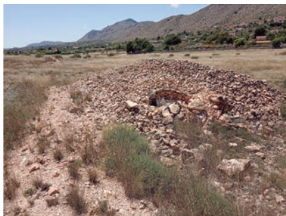
Figura 4. Construcció en ruïnes
