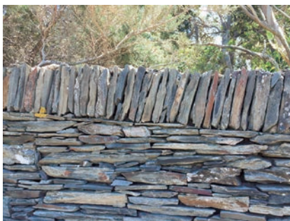
Figura 10. Paret de tanca a dues cares i coronada amb rastell (foto: Miquel Figueras, 2019)
