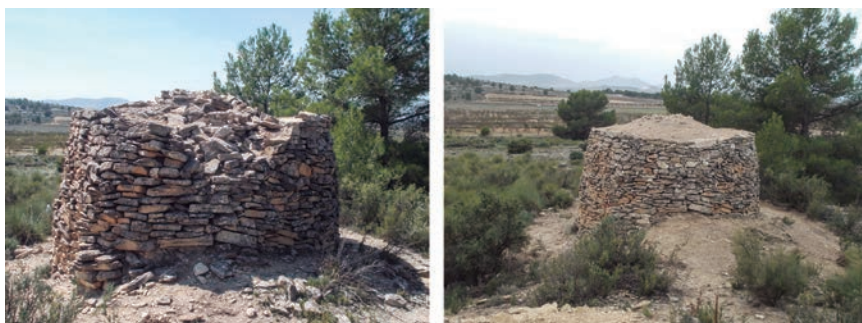
Figura 9. Cuco de Isabelita, antes y después de la reconstrucción
