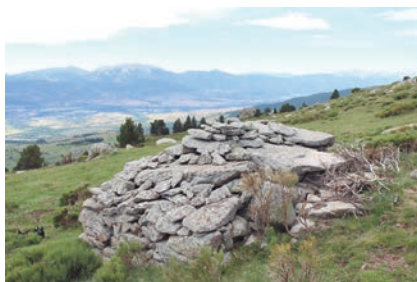
Figura 4. Orri de Baix-3 (WK 13073), barraca de grans lloses amb dormidor situada a la part baixa d'una pleta en pendent
