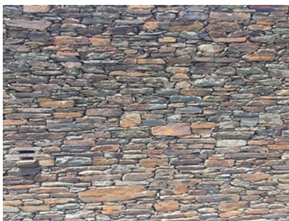
Figura 9. Paret amorterada per darrera, sense traspuar es morter (foto: Miquel Figueras, 2019)
